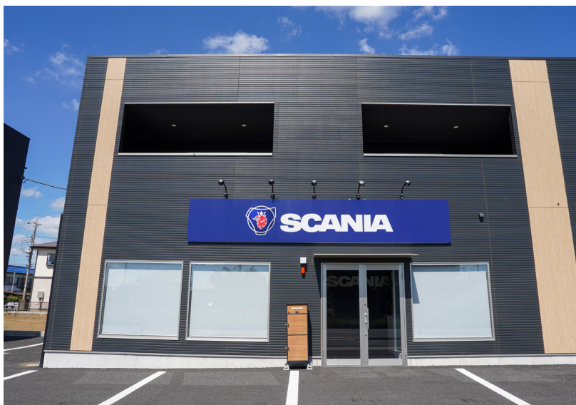
千葉県八街市に新設されたスカニアのセールスオフィス外観
