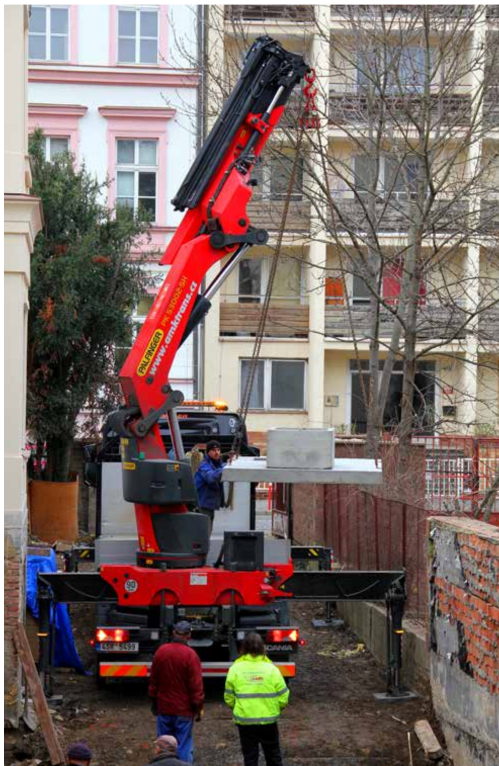
Manipulaci znesnadňovala hustá zástavba i nemožnost naplno vysunout podpěrné nohy.
