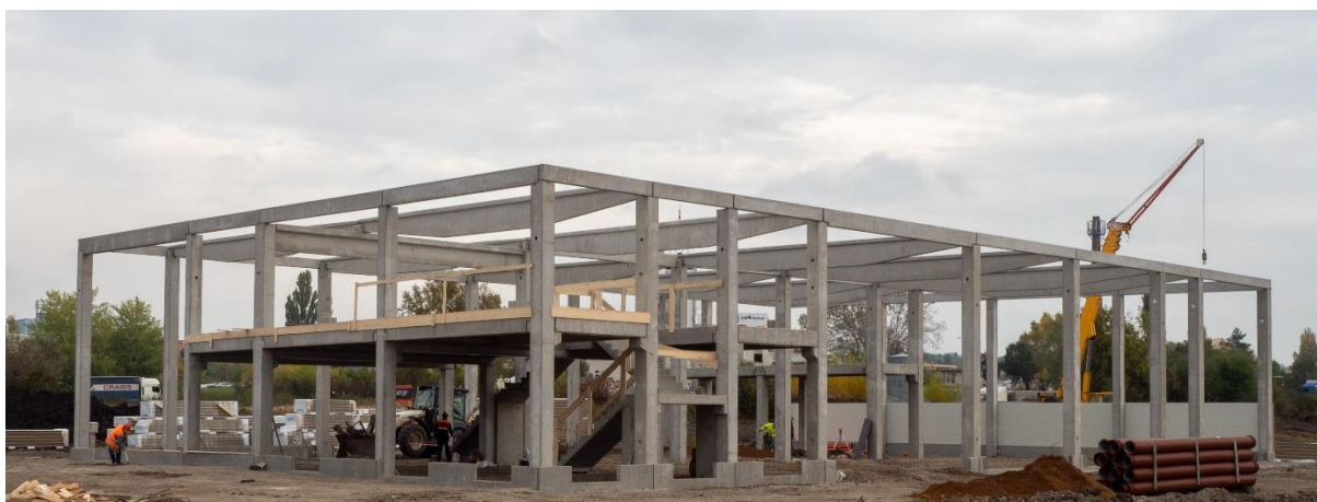
Stav výstavby nového servisu k 21.10.2020
